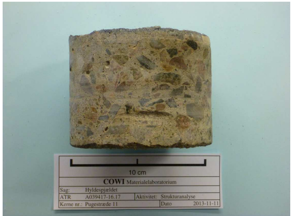
Kerne K2: Ydre overflade opad. Der ses aftryk af Ø5 mm rundjernsarmering med dæklag på 50 mm. Stentilslag er i middel mængde og velfordelt.
