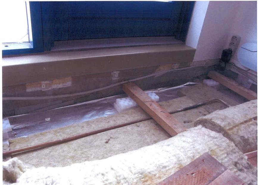
Facade ved hoveddør
