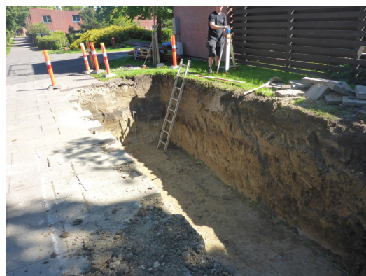
Udgravning ved Færgeslippen
