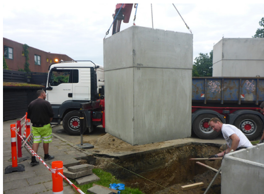
Her ses nedsænkning af betonbeholder på Store Torv's parkingsplads
