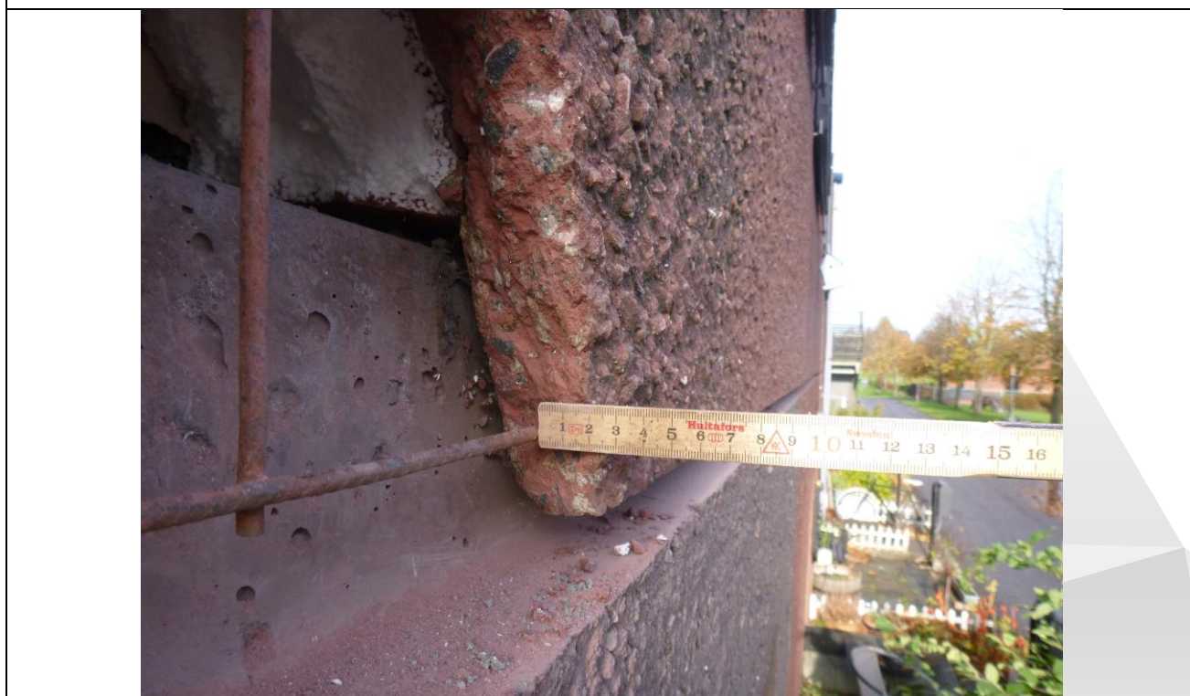
Foto 6: (P1090416.JPG). Elementunderside "tåen" med armering. Her er armering i midten og har dæklag på 20 mm til både for- og bagside.
