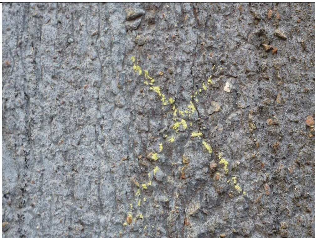
Foto 18: (P1180623.JPG) Typiske revner i blåt element.
