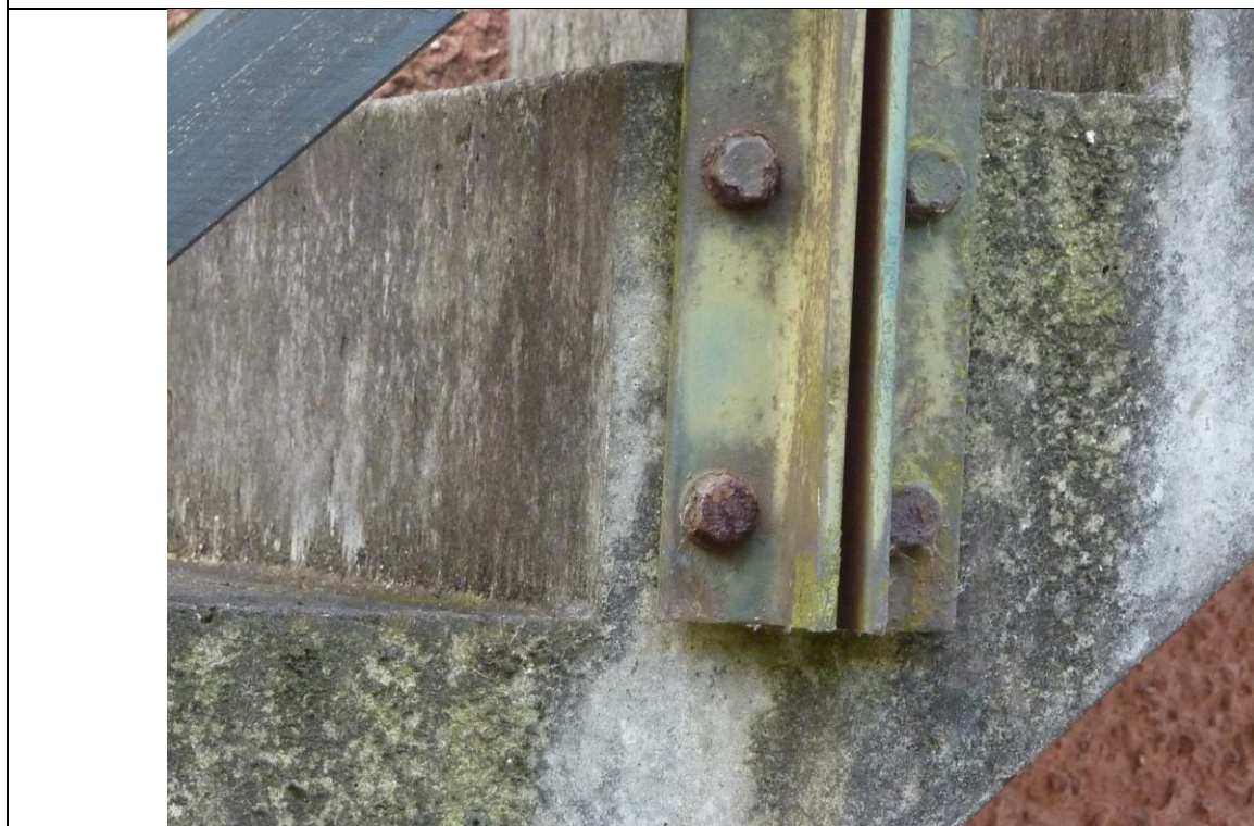
Foto 16: (P1180606.JPG) Boltefastgørelser er meget rustangrebet.
