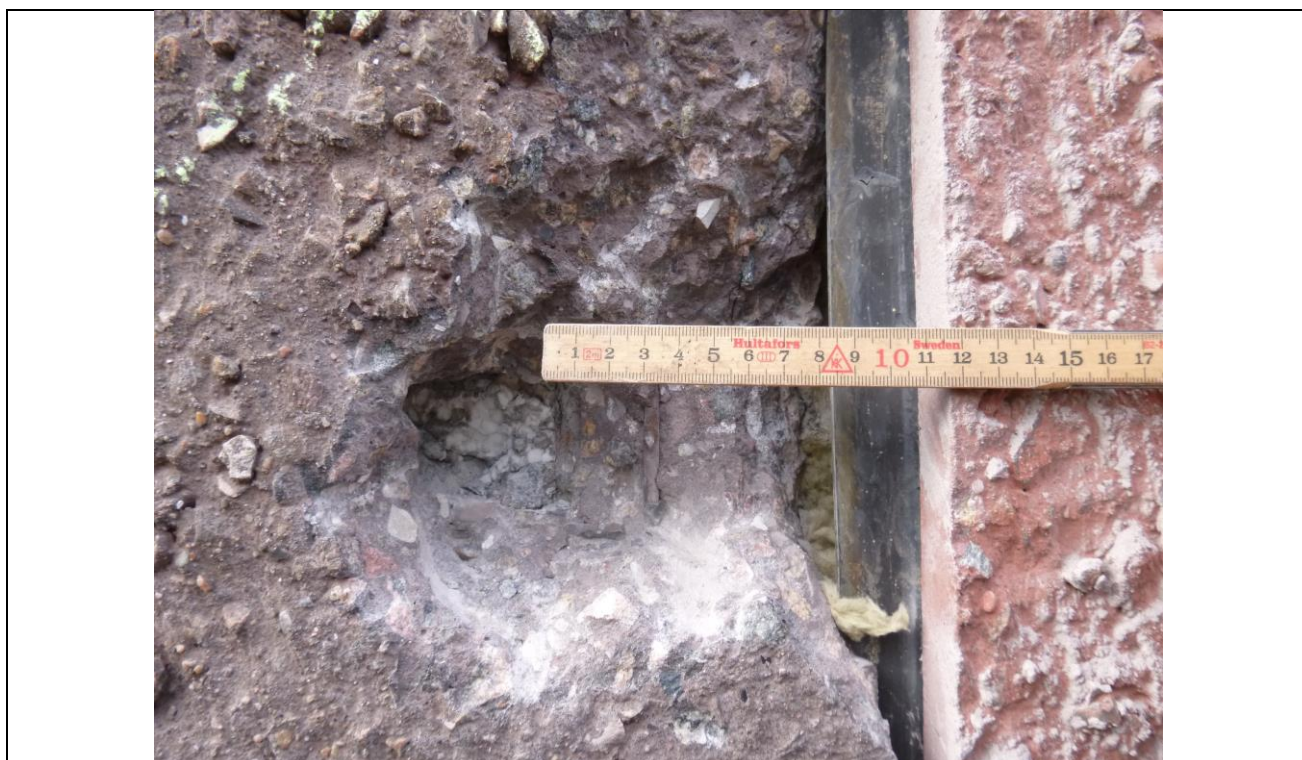
Foto 7: (P1090420.JPG). Den tykkere del ved lodret fuge er 10cm bred.
