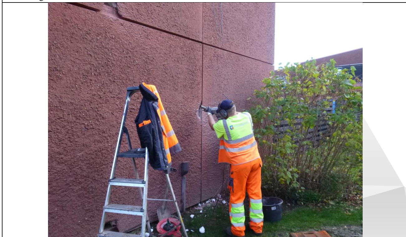
Foto 2: (P1090396.JPG) Boring for at finde tykkelse af isoleringslaget.
