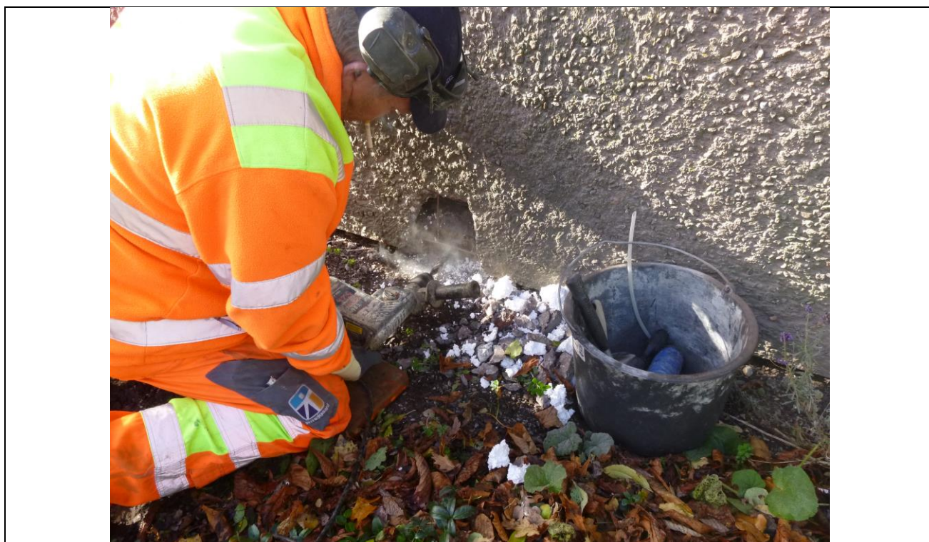
Foto 5: (P1090410.JPG). Boring i sokkel for at bestemme isoleringstykkelse.
