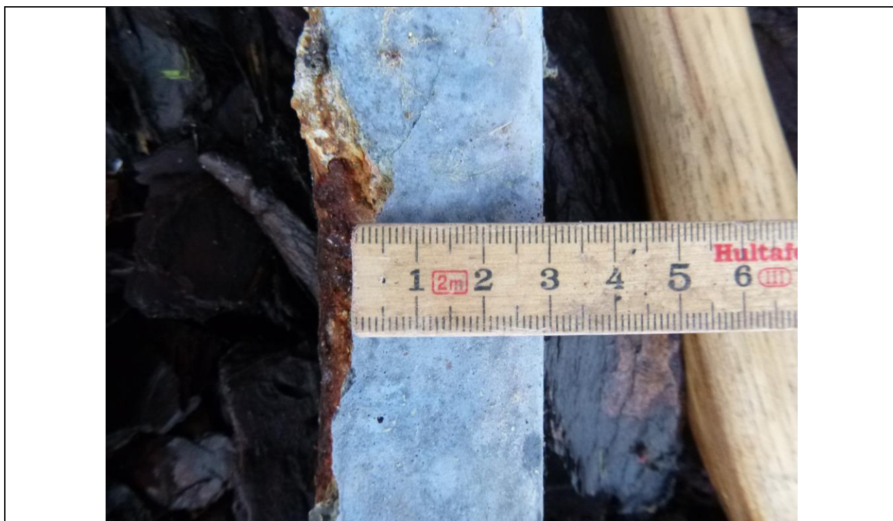
Foto 11: (P1090555.JPG) Underside af element. Dæklag fra bagside er 3 cm og fra forside ca. 0,5 cm.
