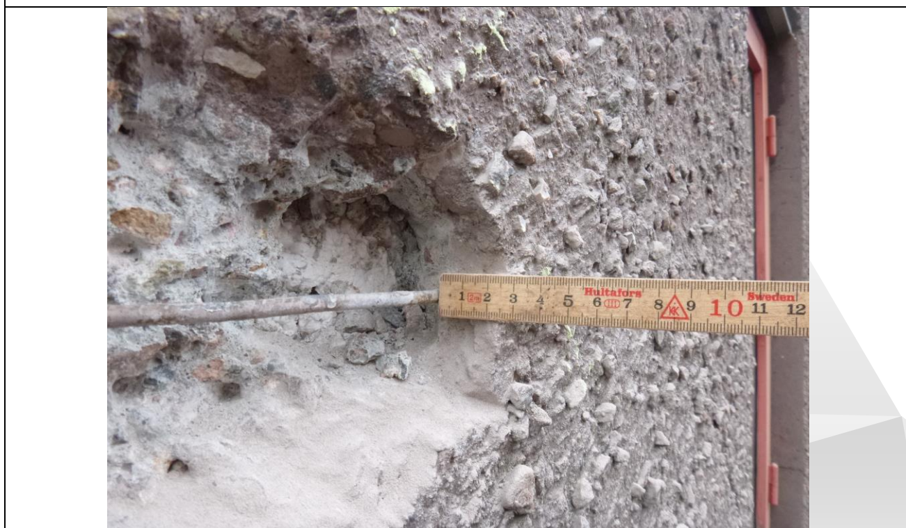
Foto 8: (P1090452.JPG). Dækklag på armering er over 20 mm.
