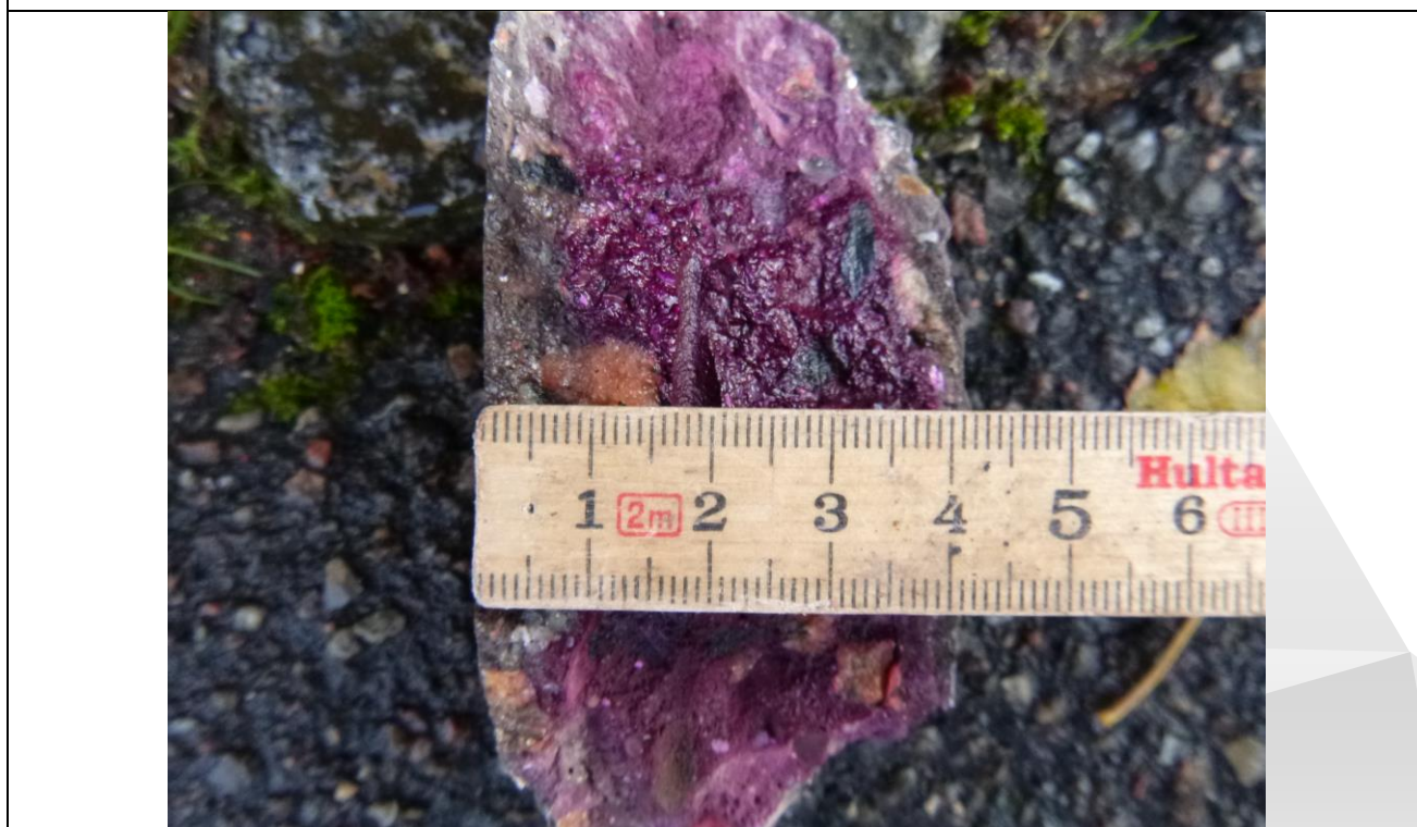
Foto 12: (P1090563.JPG) Karbonatisering: 3 mm fra forside og 5 mm fra bagside.
