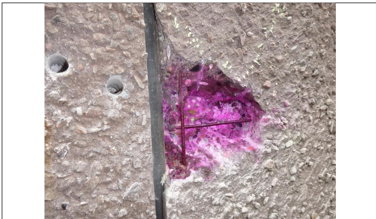
Foto 9: (P1090454.JPG). Påføring af phenolphthalein viser, at betonen praktisk talt ikke er karboniseret. Til venstre ses borehuller for bestemmelse af den fortykkede del af elementet og isolering i venstre hul.
