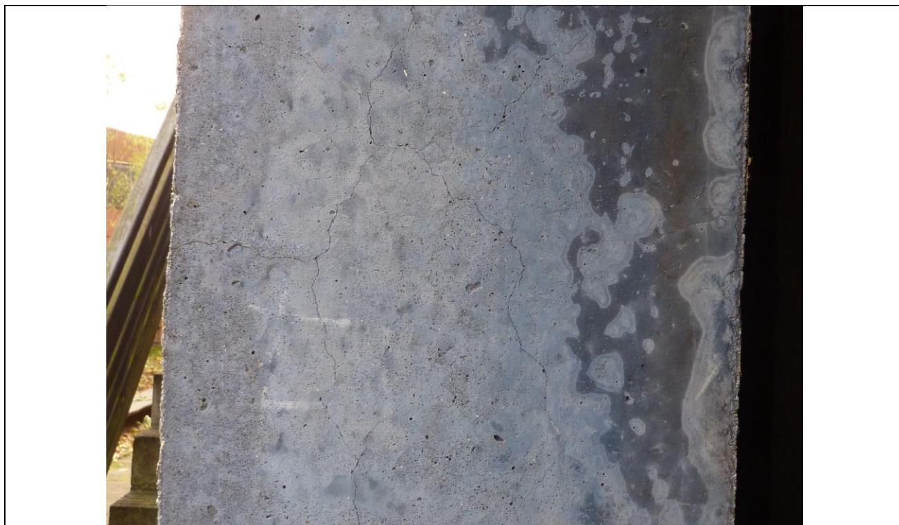
Foto 19: (P1180626.JPG) Underside af portelementbjælke.
