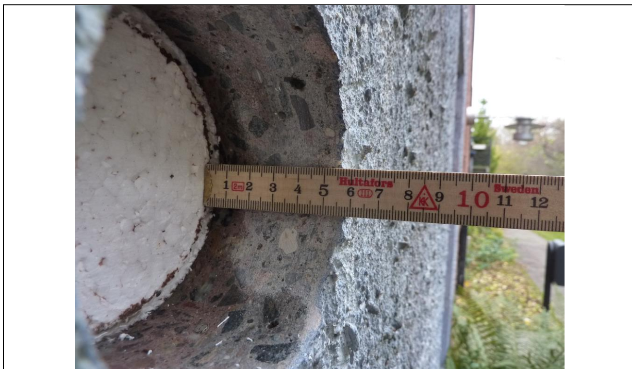
Foto 21: (P1180650.JPG) Her er afstand fra elementoverside til isolering ca. 56 mm.
