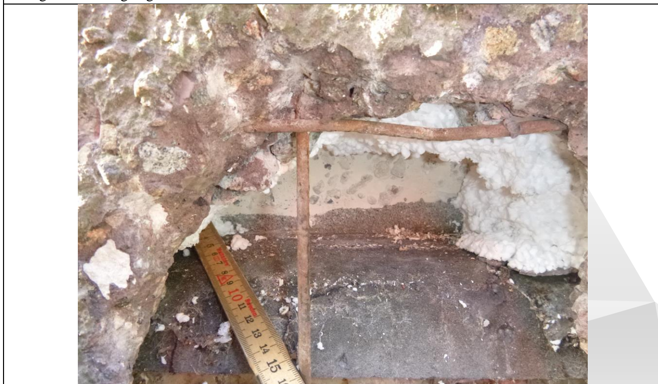
Foto 4: (P1090409.JPG) Understopning af bagvæg er intakt. Der er pap over sokkel.
