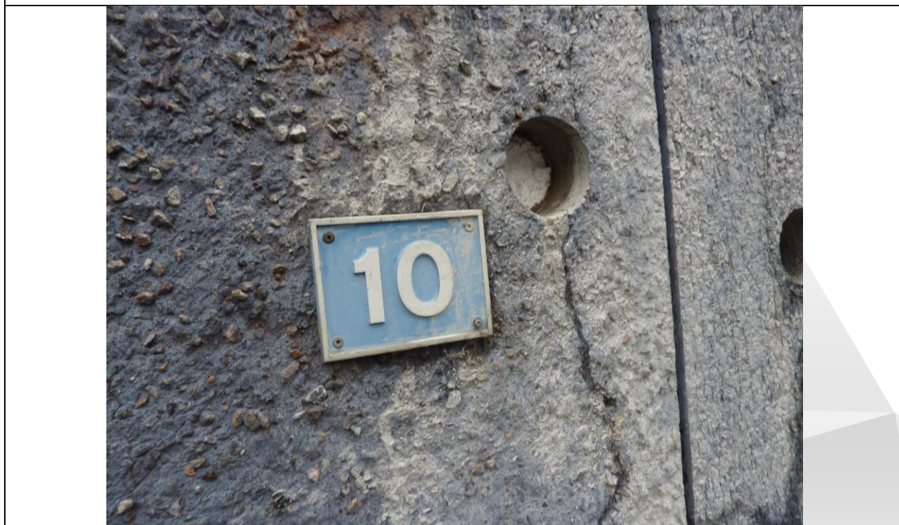
Foto 22: (P1180666.JPG) Borekerne K3 udtaget i revne i blå facadeelement. Til højre ses borehul for kerne udtaget i portelement.
