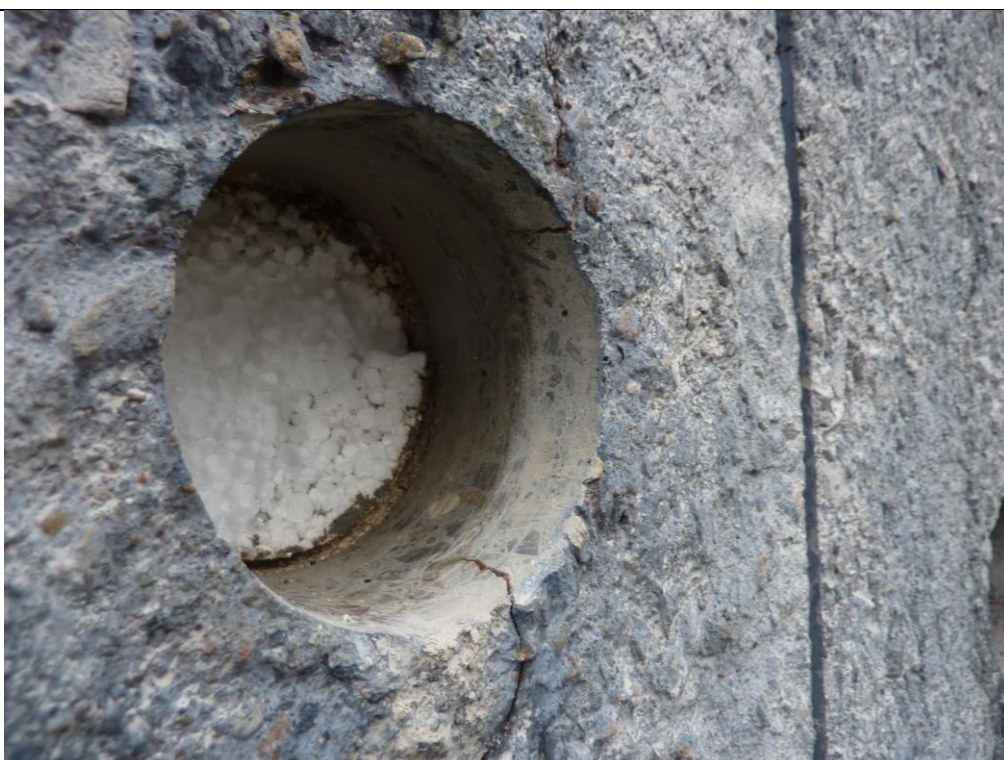
Foto 23: (P1180668.JPG) Revnen går halvt ind i forpladen.
