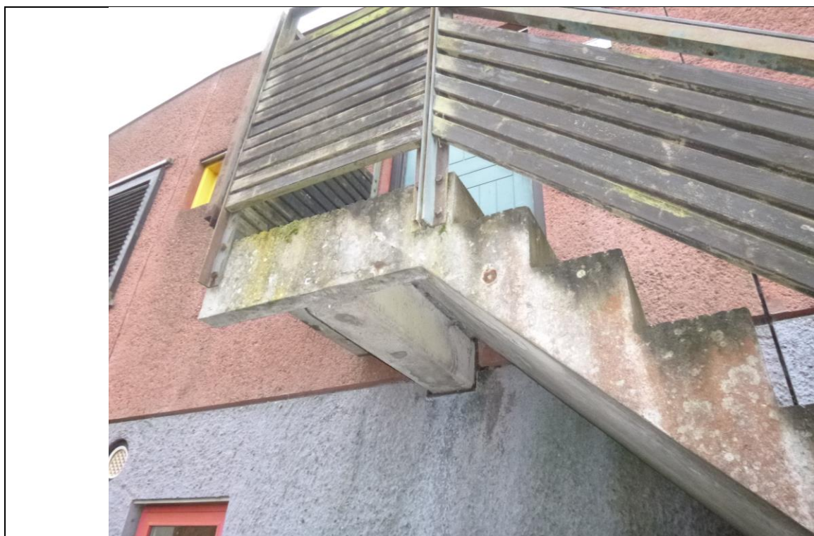
Foto 15: (P1090618.JPG) Her er udtaget kloridprøver fra underside af konsol. Der er afskallet over clamsjern. Rækværk er ret nedbrudt.
