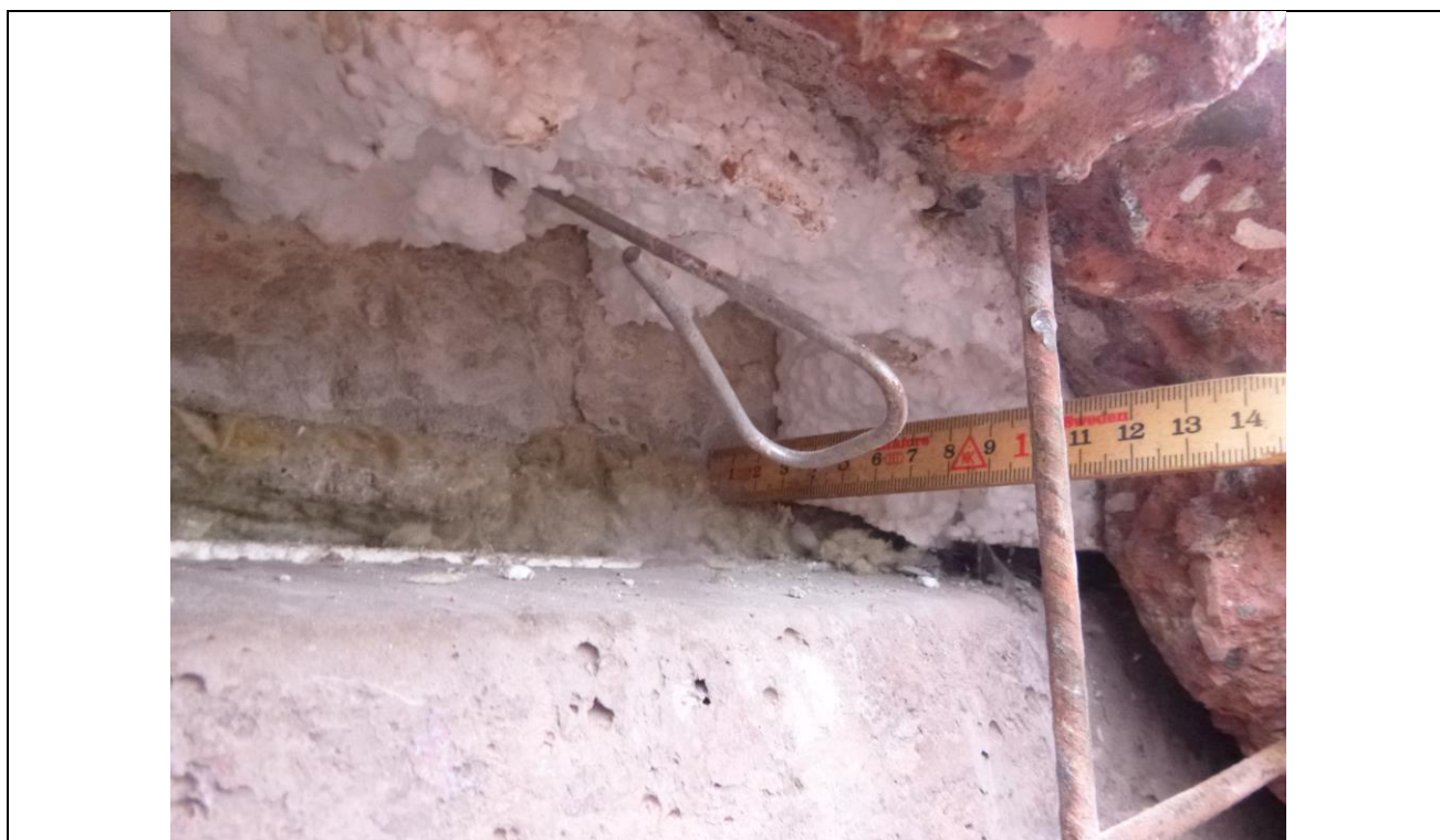
Foto 1: (P1090372.JPG) Frihugning i top af element. Fra forside af element til forside af bagvæg er den projekterende afstand 160 mm. Armering er 5 mm tentorstål.
