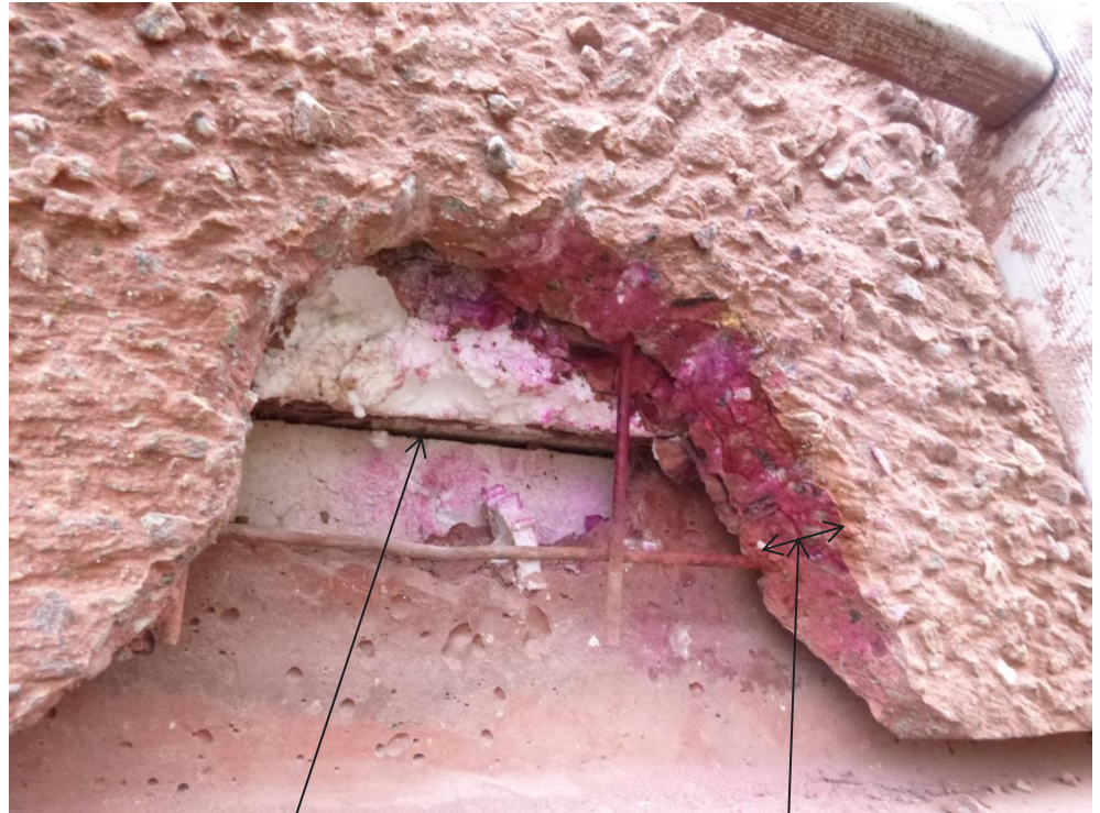
Frihugning i vandret samling mellem to elementer. Isolering ( t=30\text{ mm} ) i nederste element ses ført helt op til kant af element. Polystyrol i overstående element støder her helt op til underliggende. Dæklag på armering er ca. 30\text{ mm} fra forsiden og ca. 10\text{ mm} fra bagsiden. Karbonatiseringszonen er 2\text{-}3\text{ mm} .
