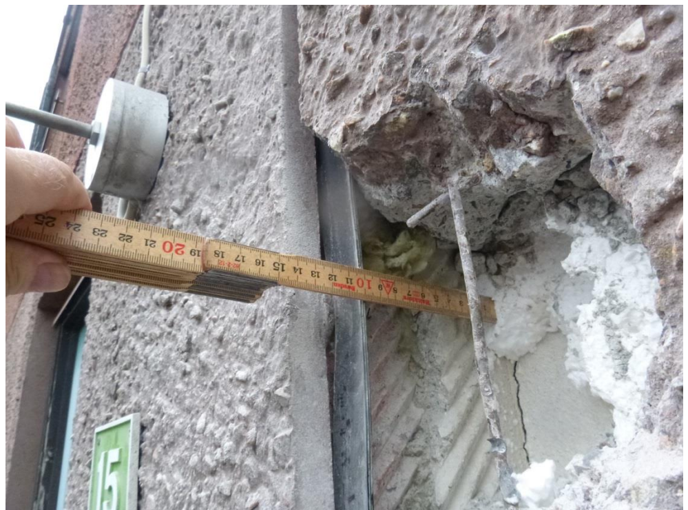
Lodret samling mellem to elementer:
