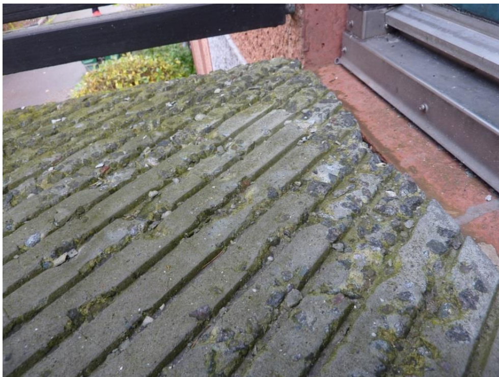
Eksempel på forvitret betonoverflade på overside af repos.
