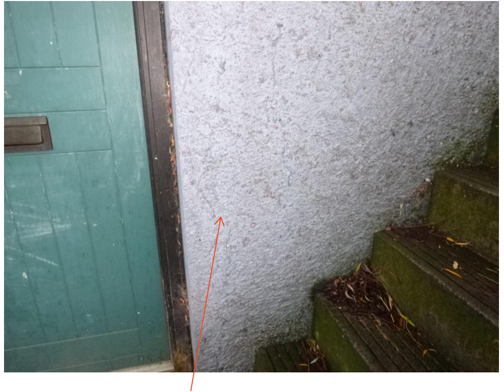
Hjortelængen 10. Revnedannelser i blå facadeelement
