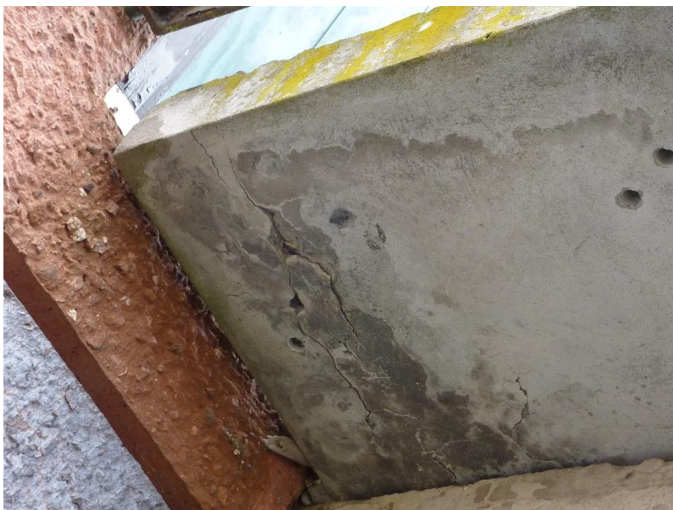
Eksempel på skade på underside af repos.
