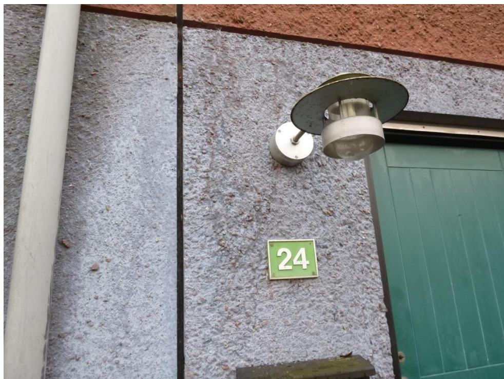
Bryggerlængen 24. Revnedannelser i facadeelement mellem nummerskilt og lampe, mørke linjer.
