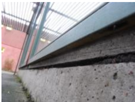
Manglende vandnæse ved bundkarm
