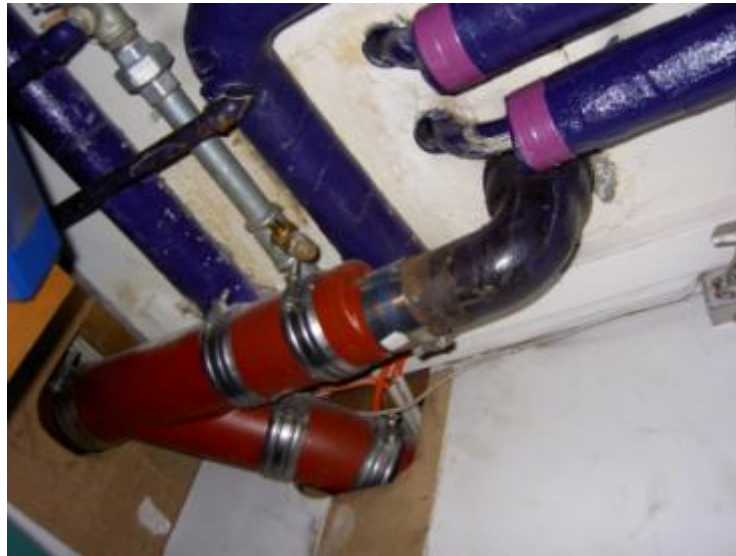
Eksempel på udskiftet støbejerns rør
