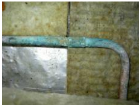
Eksempel på varmerør under gulv med udvendig tæring.
