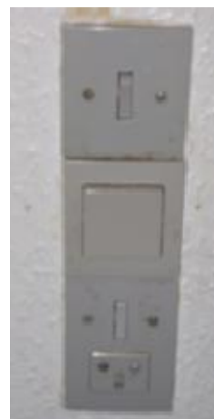
Eksempel på afbrydermateriel under udskiftning.
