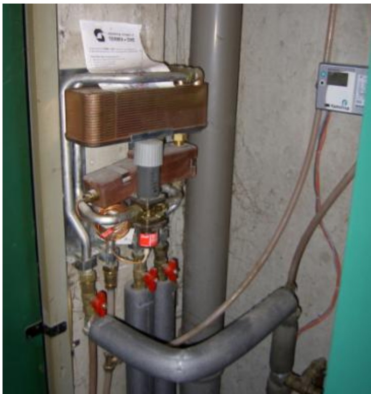
PVC afløbsrør i teknik skab
