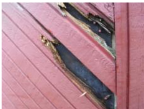
Nedbrudt facadebeklædning
