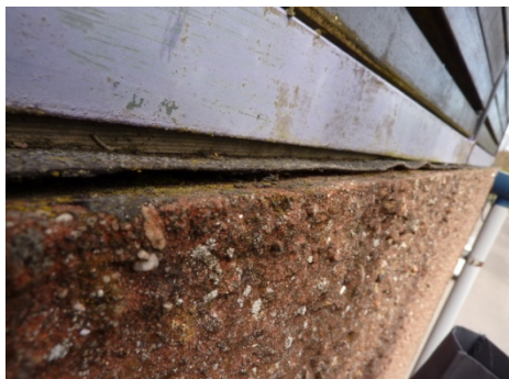
Nærbillede af afslutning/skrå hældning ved "murkrone"
