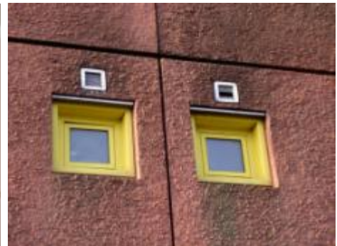
Afkast ventil fra badeværelses ventilator på facade.
