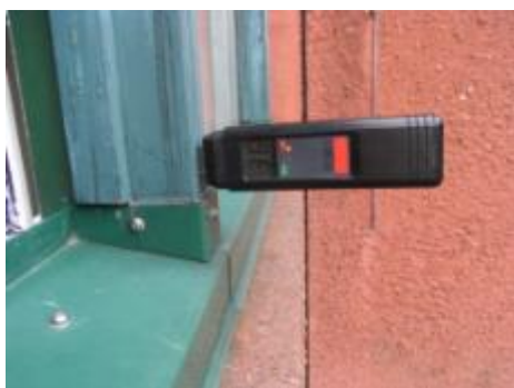
Vestvendt vindueskarm, over 28 % fugt, Tømmerstræde 17
