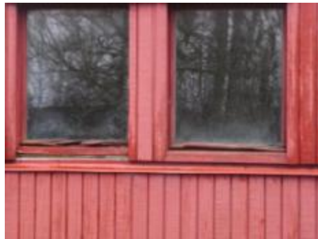
Nedbrudt bundramme, vinduesparti
