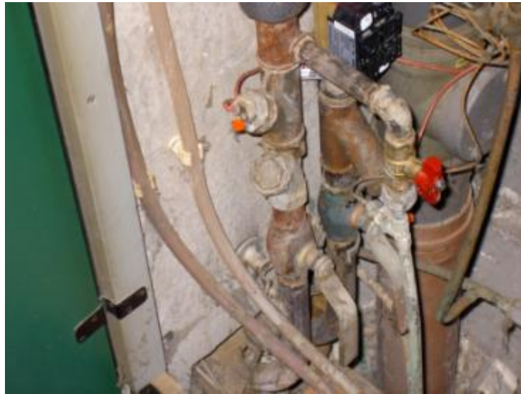
Typisk fjernvarme forsyning til lejligheder.
