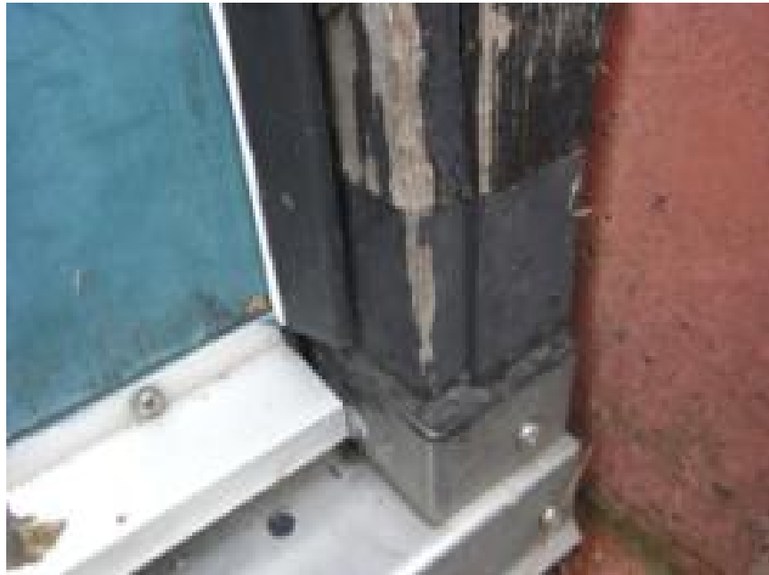
Reparation ved hoveddør, Åleslippen 18
