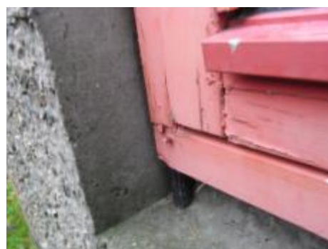
Synlige søm ved karm, Torveslipperne 11 samt begyndende råd i bundkarm
