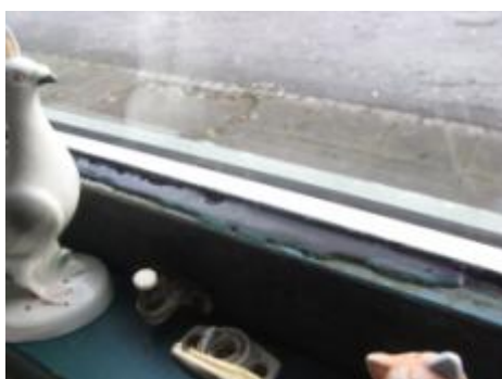
Indvendig kondensvand, Åleslippen 63
