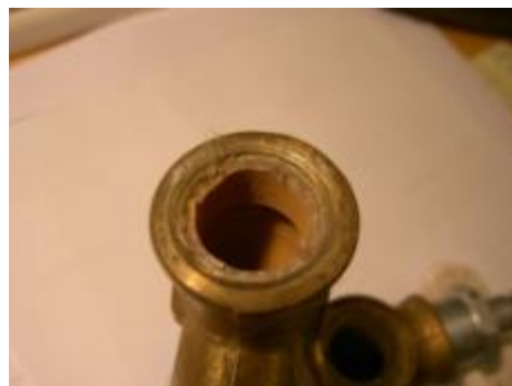
Typisk brud på nyere messing installation. Disse skader sker oftere og oftere.
