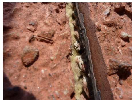
Stopning mellem elementerne, Storetorv 6
