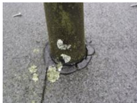
Sprøde fuger ved gennembrydninger
