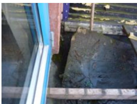
Overlæg ved ny tagpap, vedhæftningsslip Stående vand på tagterrasse
