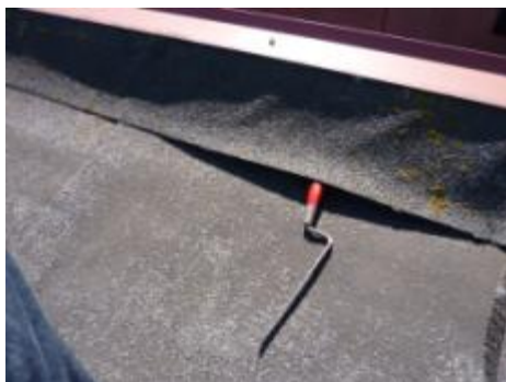
Vedhæftningsslip ved overlæg
