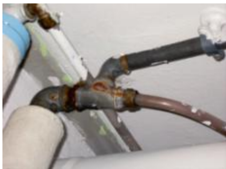
Tærings skade i stålrørs brugsvandsinstallation.
