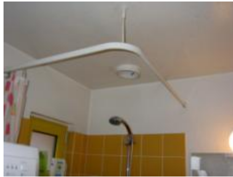
Friskluftskanal i badeværelse
