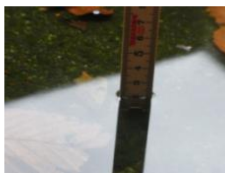
Overlæg ved ny tagpap, vedhæftningsslip Stående vand på tagterrasse
