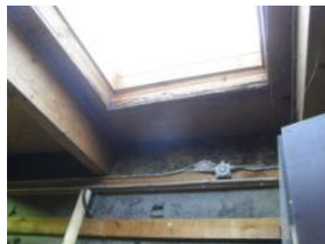
Frit isoleringsmateriale i arbejdsrum
