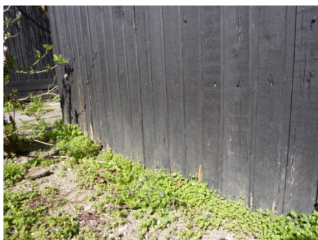
Nedbrudt træværk ved skure
