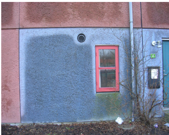
Kuldebroer i kanten af betonelementer
