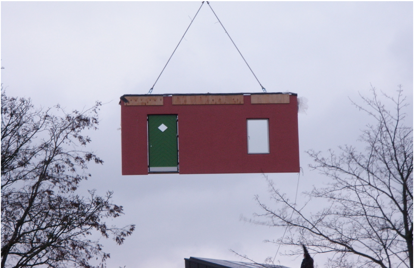
Facadeelement til Høkerlængen 2 hejsese på plads
